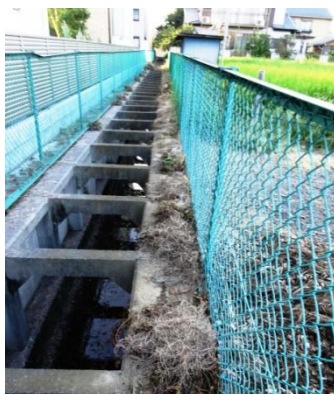
事前の除草状況
